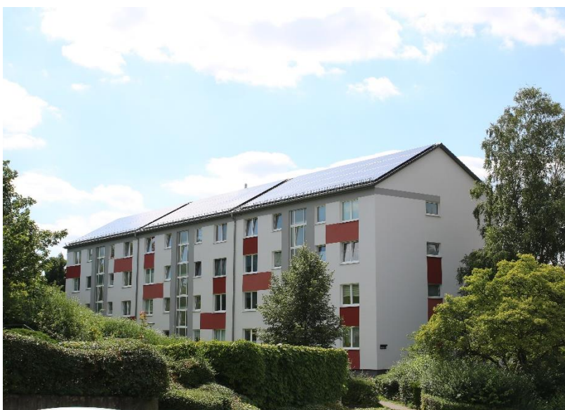
3-41 PV-Anlage auf einem Mehrfamilienreihenhaus im Quartier (EARG)
